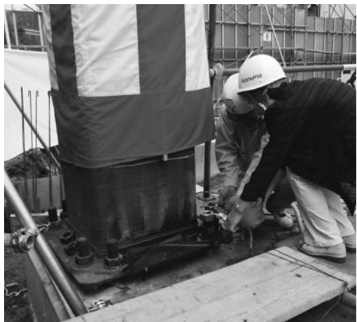
紅白の幕が巻かれた柱のボルトを締めている様子。
