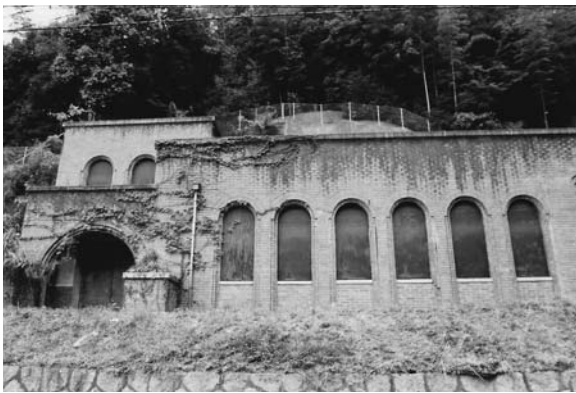
己斐調整場送水ポンプ室 西区己斐東一丁目7-7
